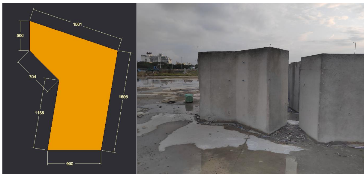
图1.3.3-16桁架式升降网箱混凝土重力锚示意图
