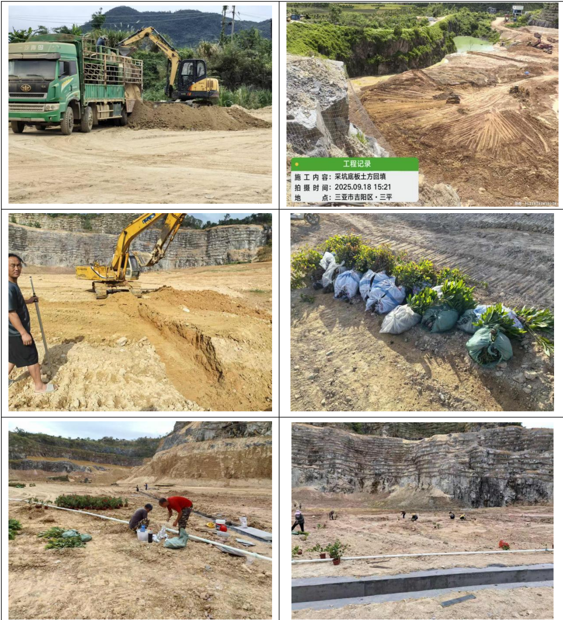
图 3 矿坑底板治理施工过程中照片
