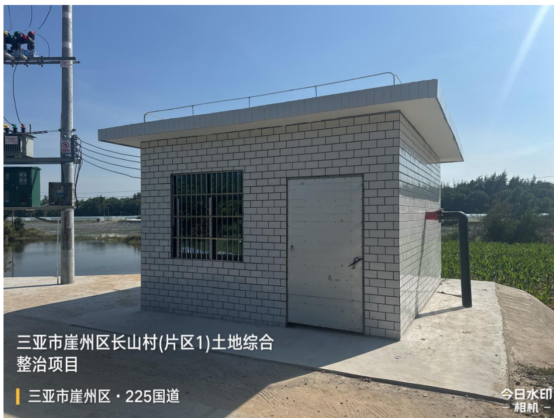
图 3-3-9 灌溉水源实地照片
