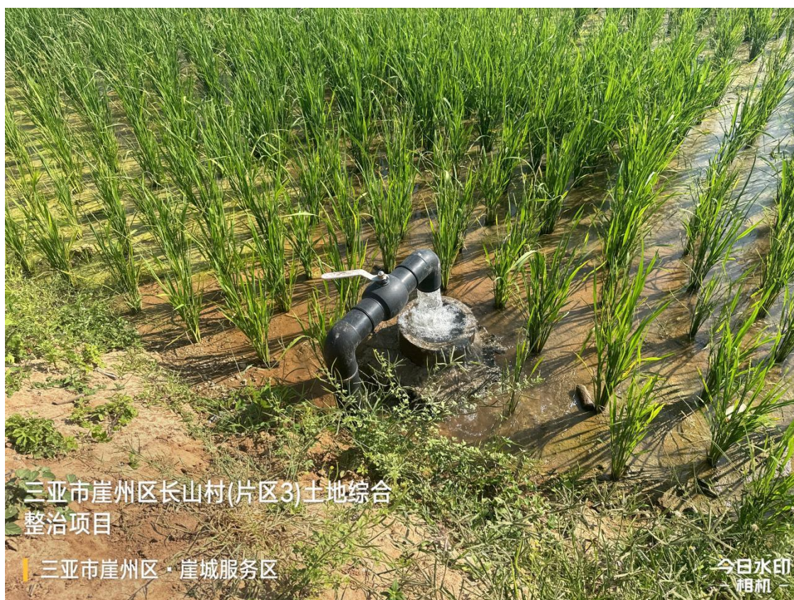
图 3-6 放水口实地照片
