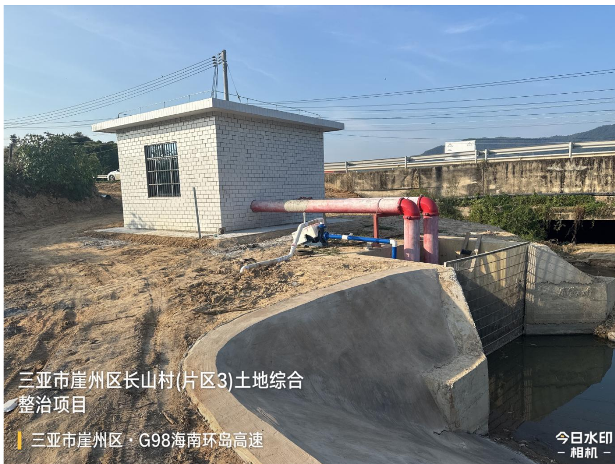
图 3-12 泵站实地照片
