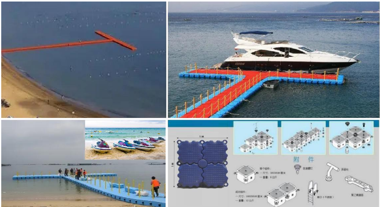
图 1.5-6 入海浮筒栈桥结构示意图
