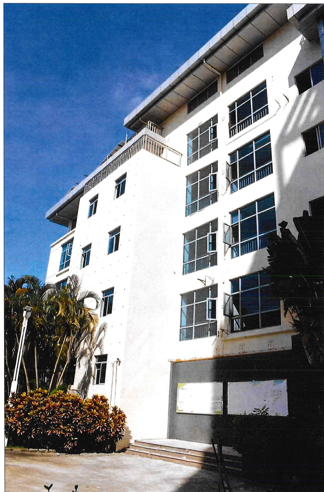
现场现状照片
