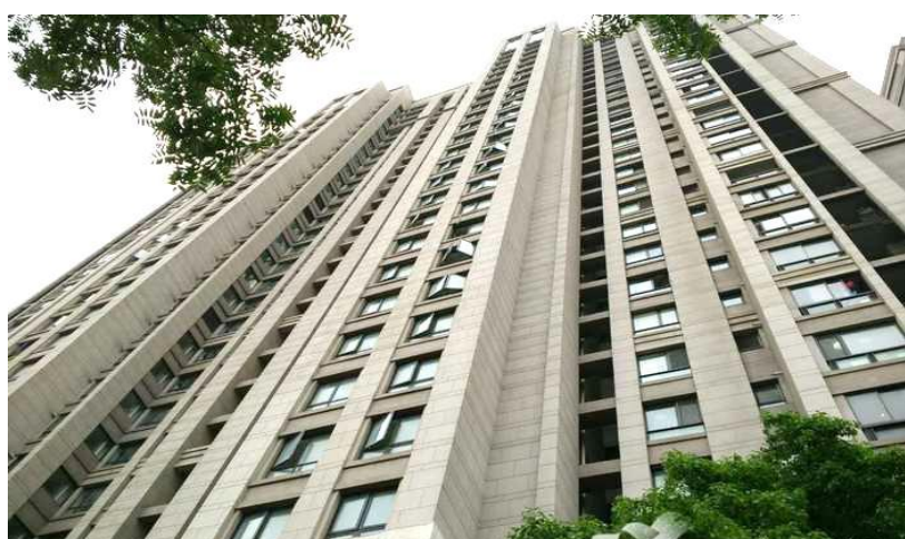
图1 沿主次干道、景观路，阳台封闭式处理
