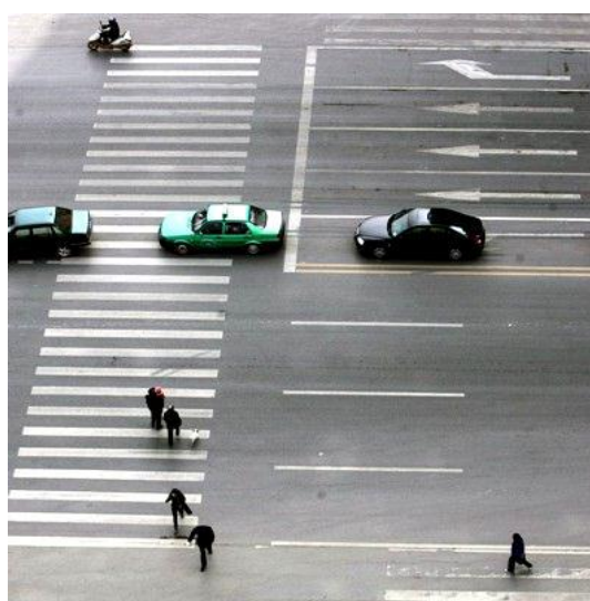
机动车停止线距人行道过近
