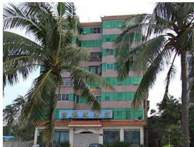
建筑色彩不合理
