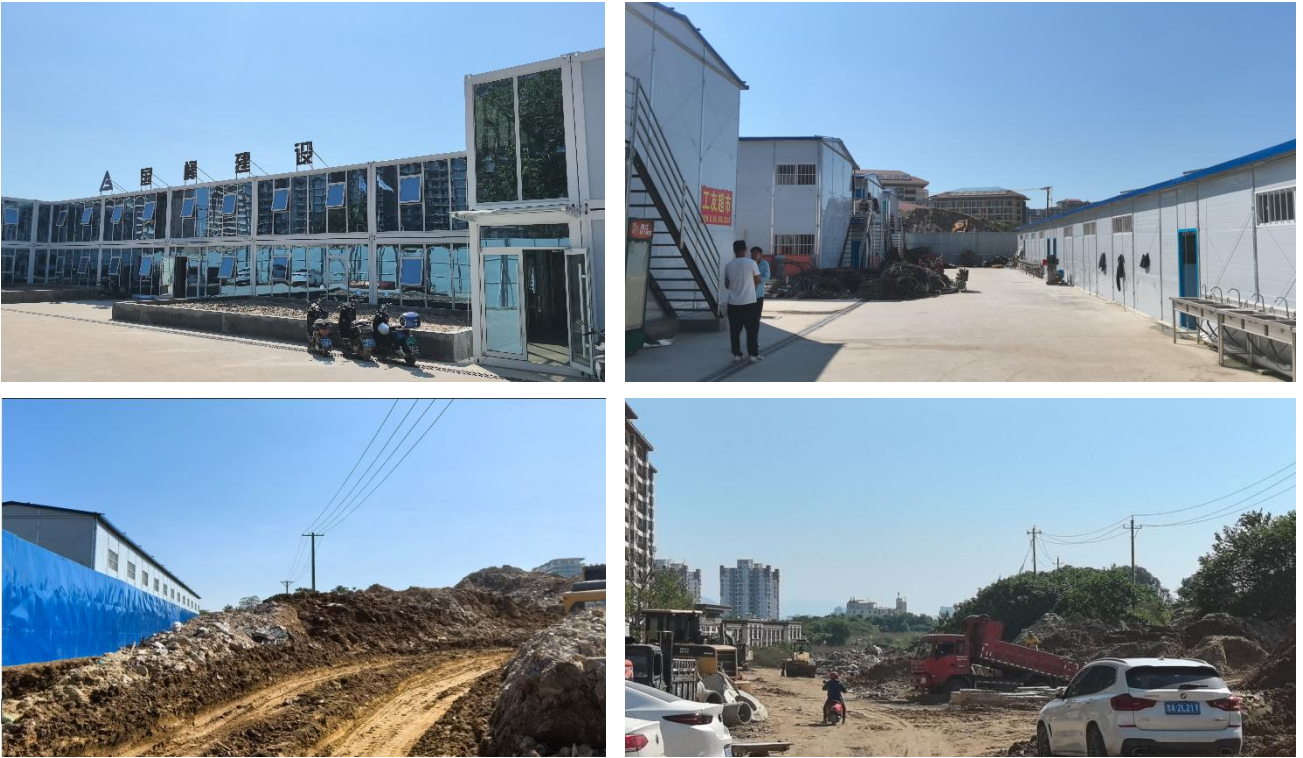
图2 项目现场情况
