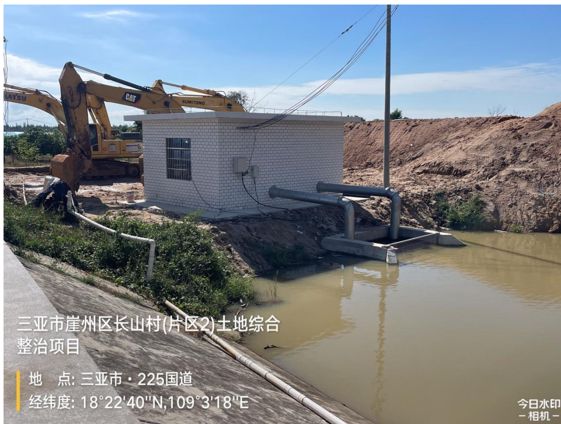
图 3-3-9 灌溉水源实地照片
