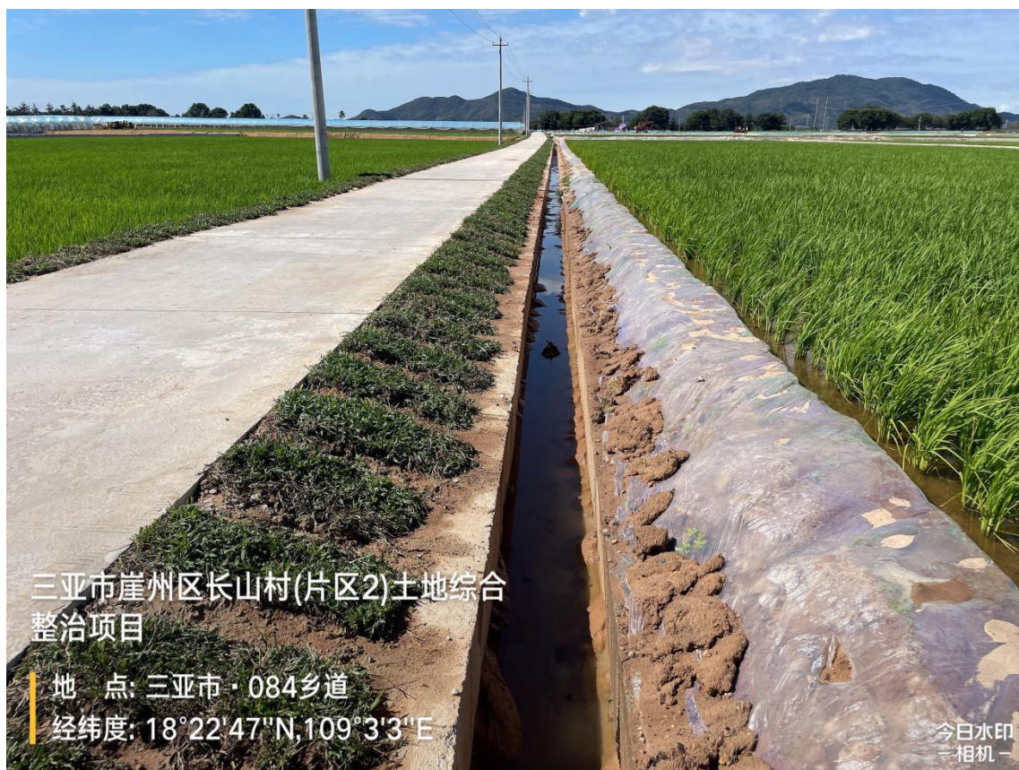
图 3-3-11 排水沟实地照片
