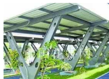
上海世博绿意停车场： 停车位采用嵌草铺装，遮阳棚基部设 有种植槽，栽植紫藤
