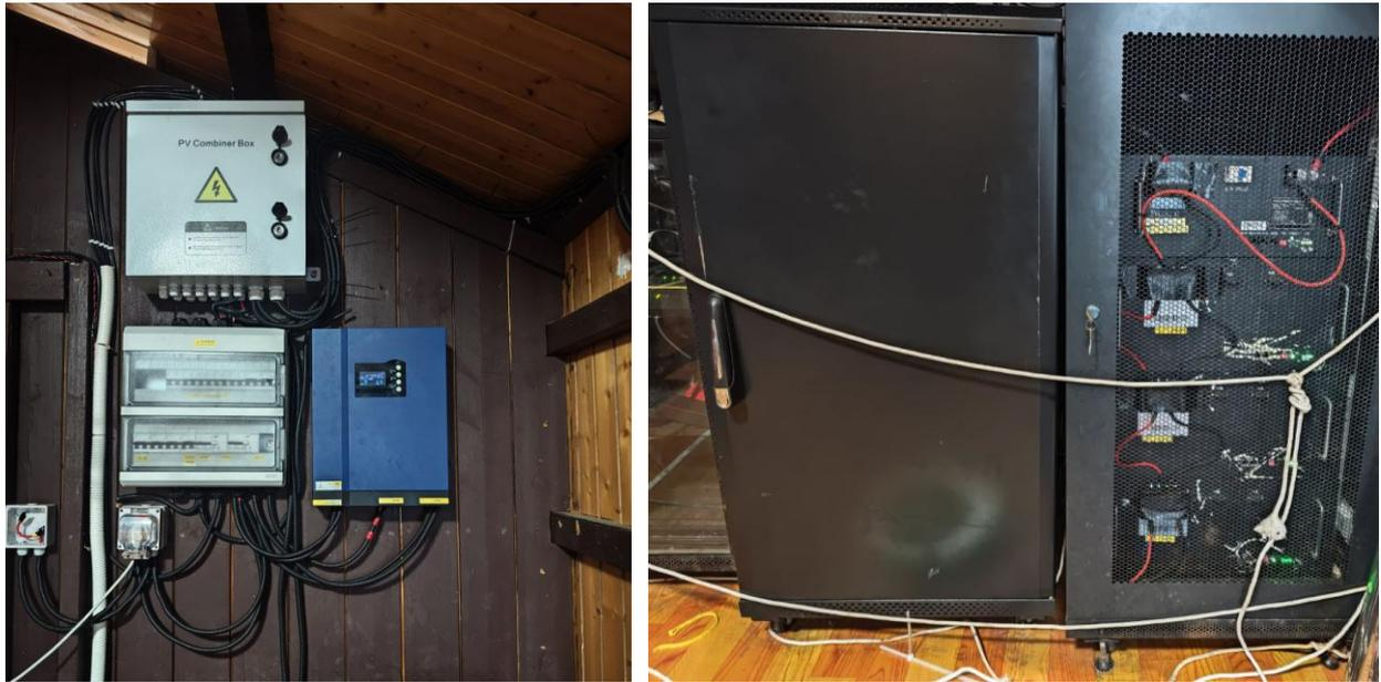
图 1.5-8 海上试验浮台供电系统
