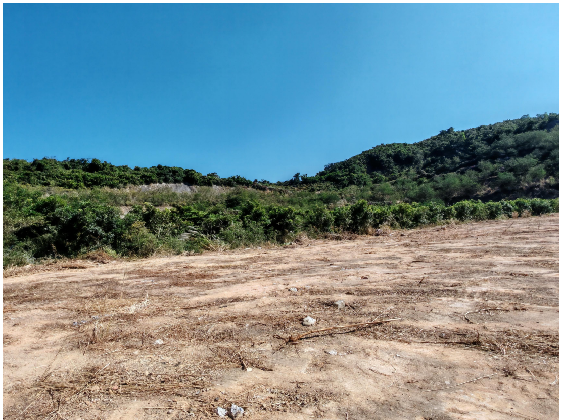
图 4.2-5 采坑东侧边坡（矿区 A1-A7 拐点）现状
