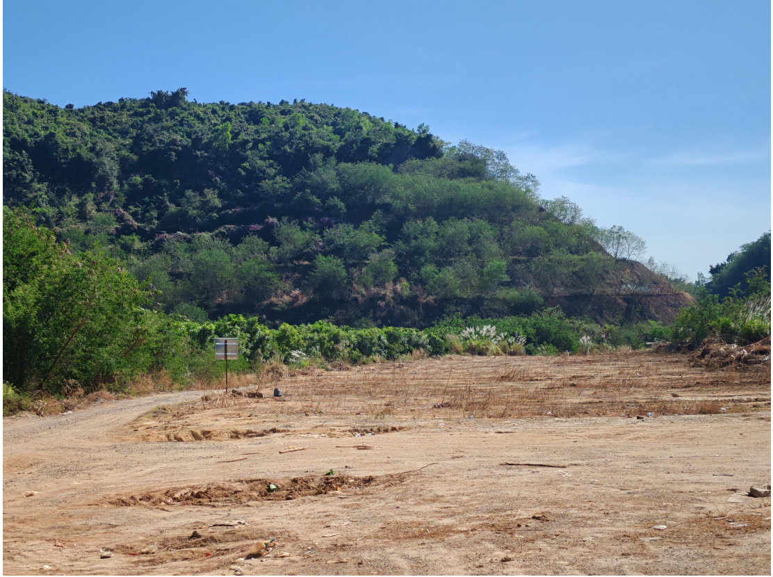
图 4.2-4 采坑东侧边坡（矿区 A1 拐点）现状
