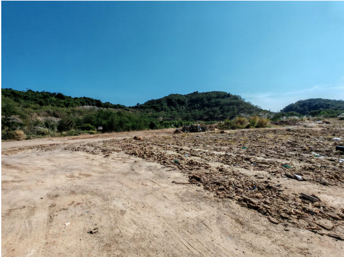
图 4.2-6 采坑底板及东侧边坡现状
