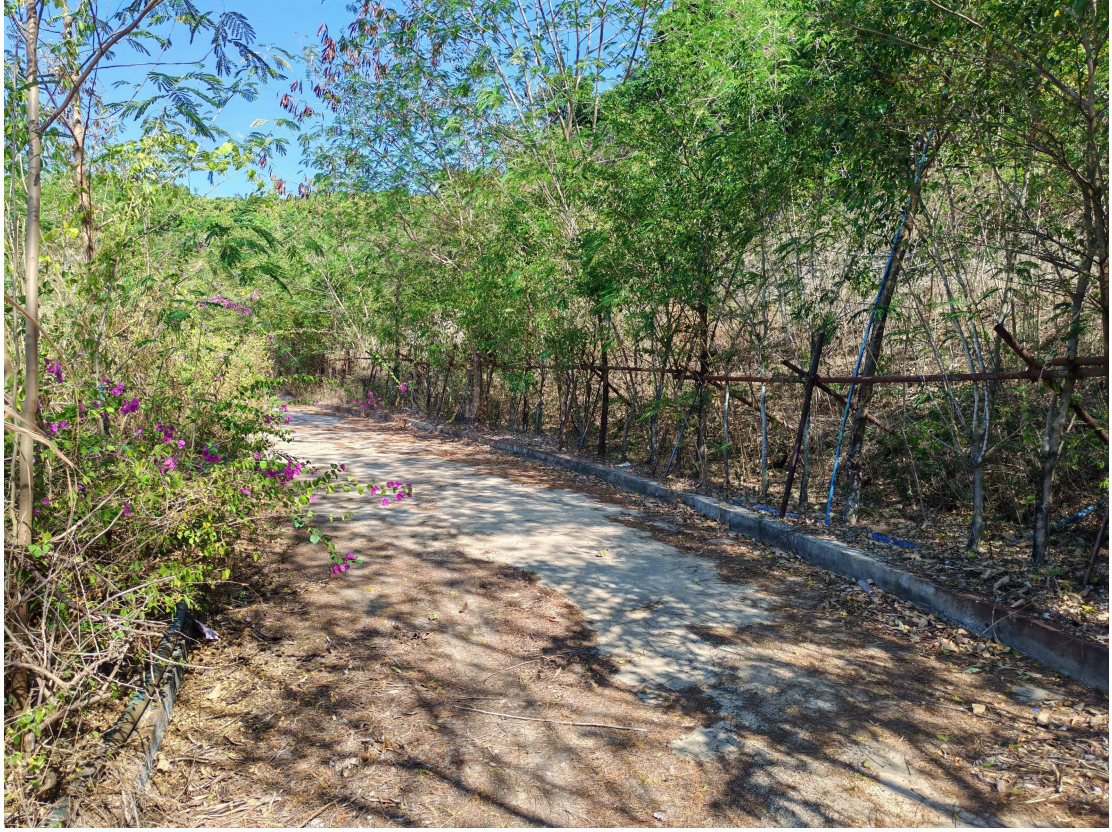
图 5.3-1 采场边坡平台硬化及植树治理
