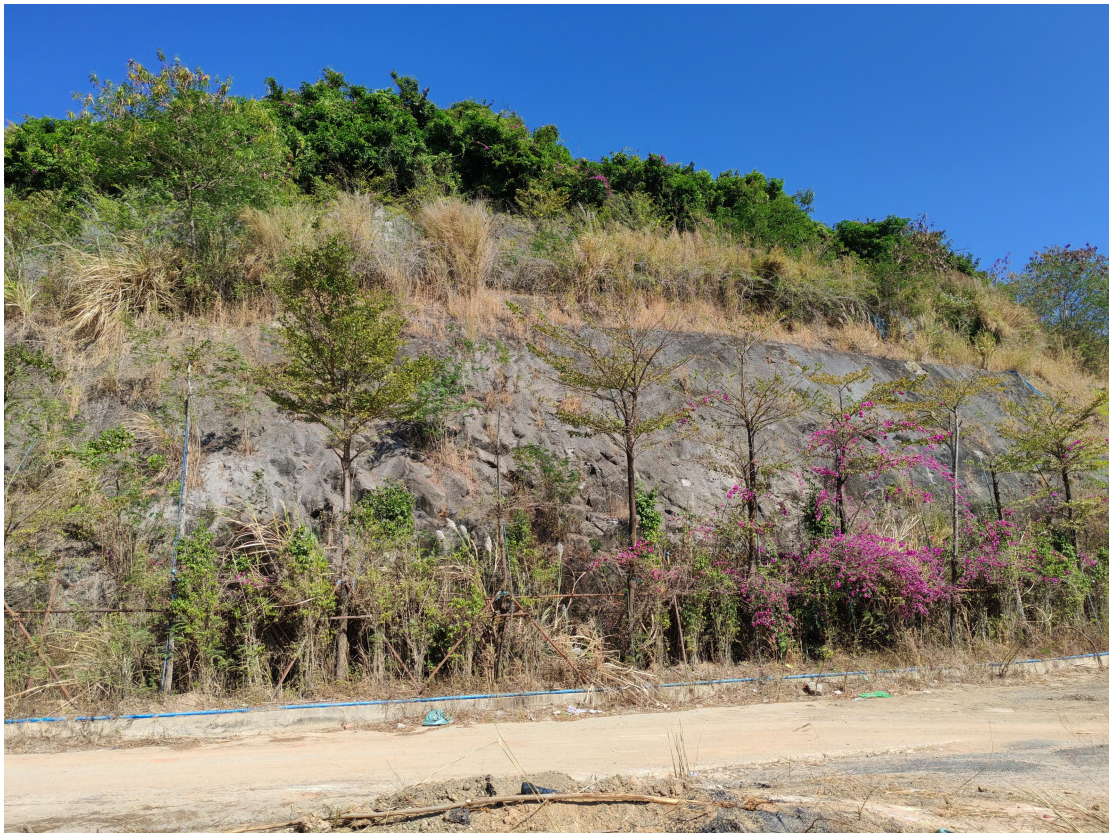
图 5.3-2 采场边坡喷浆治理
