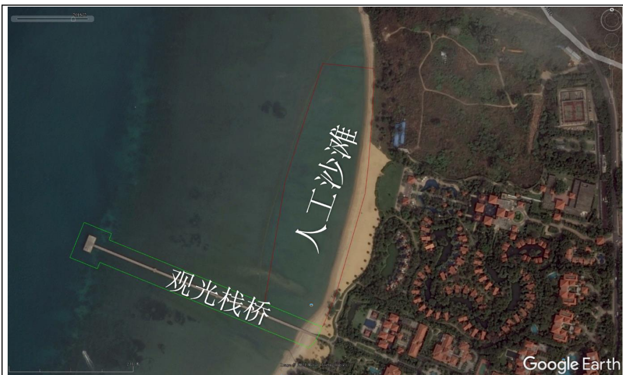
图 1.6.2-4 项目建设后海区情况（2016 年 12 月）
