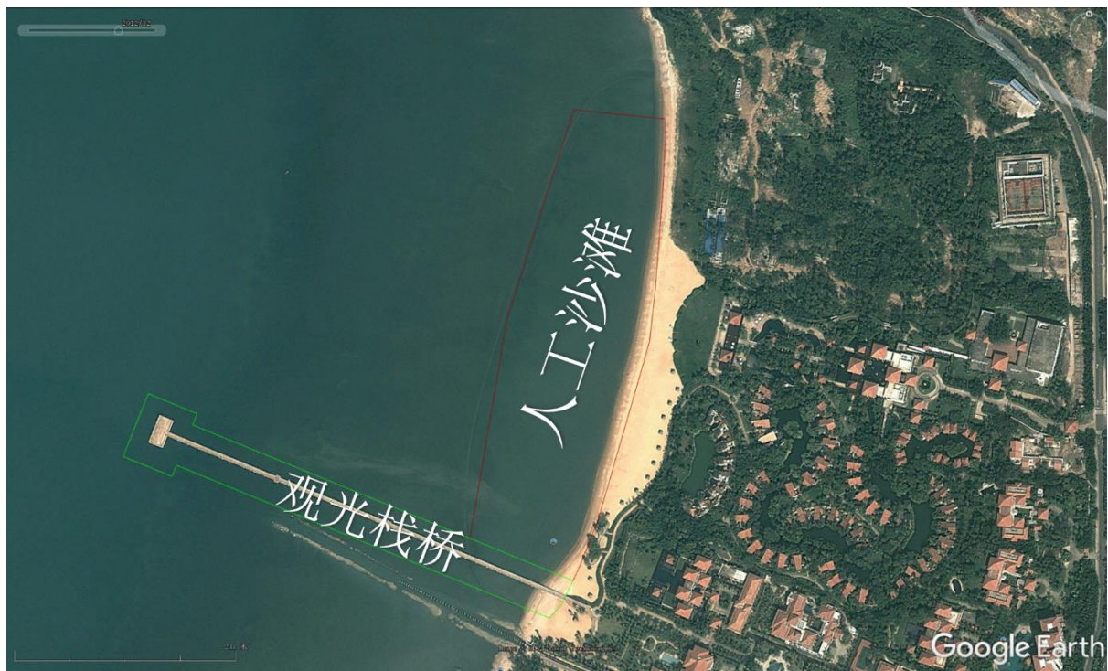
图 1.6.2-3 项目建设后海区情况（2012 年 12 月）
