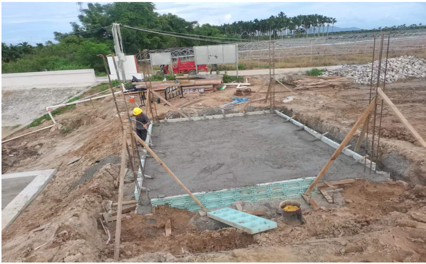
泵房基础砼浇筑
