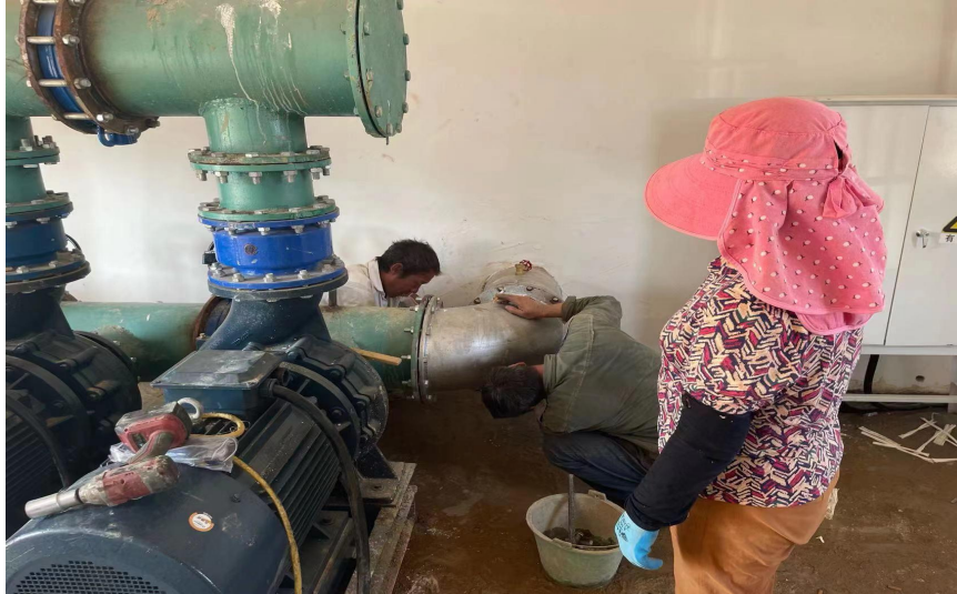
泵房设备安装
