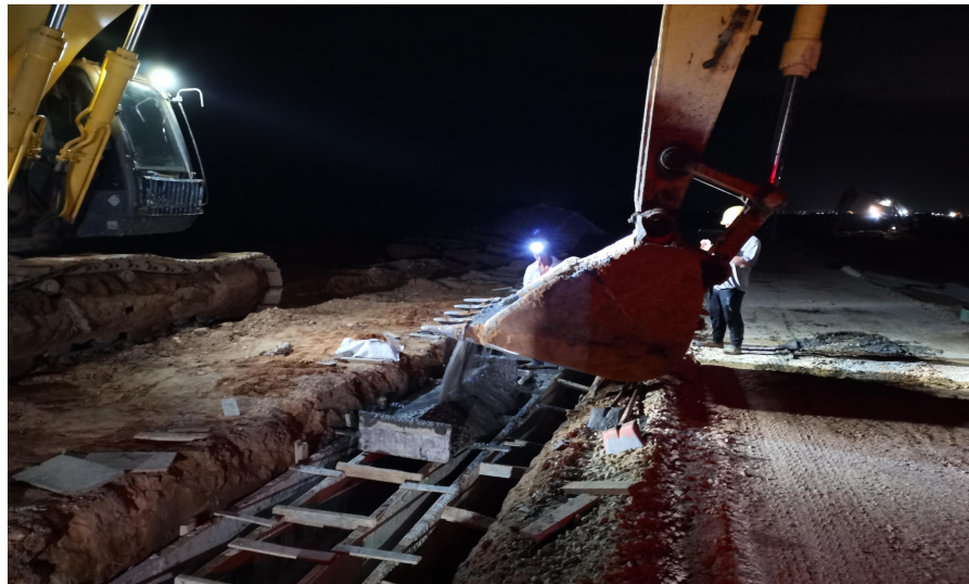
斗沟墙身砼浇筑
