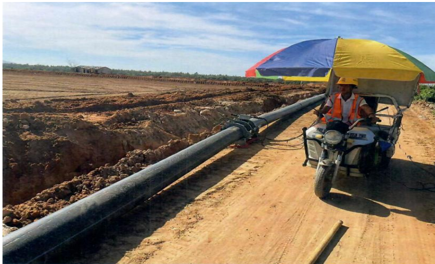
PE 管道安装
