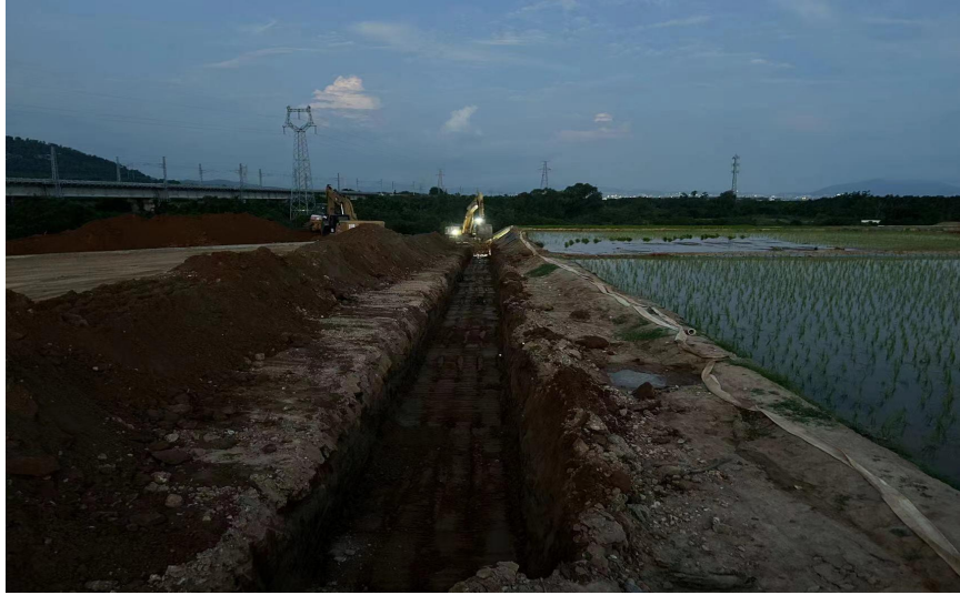
PE 管道沟槽开挖
