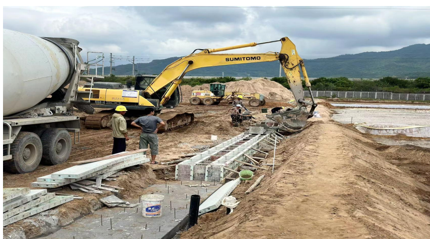
农沟墙身砼浇筑
