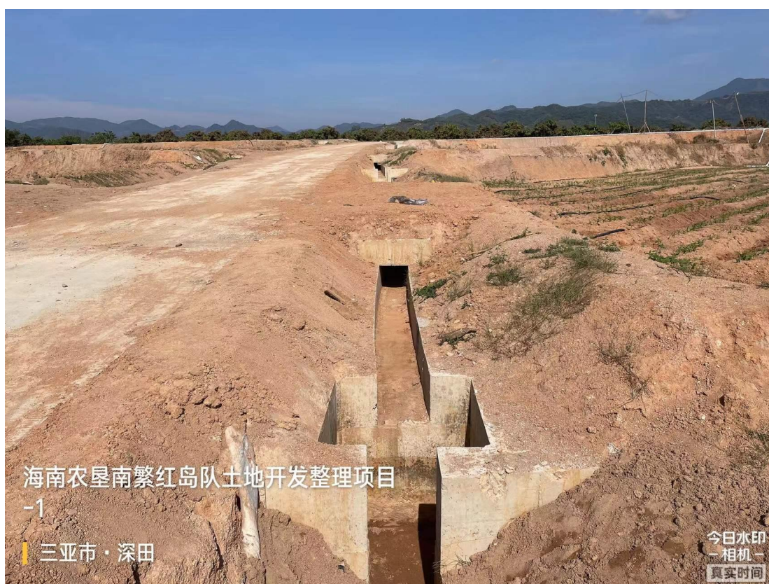
图 5-6 项目实施后现场照片 6
