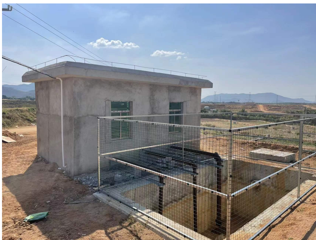
图 5-2 项目实施后现场照片 2
