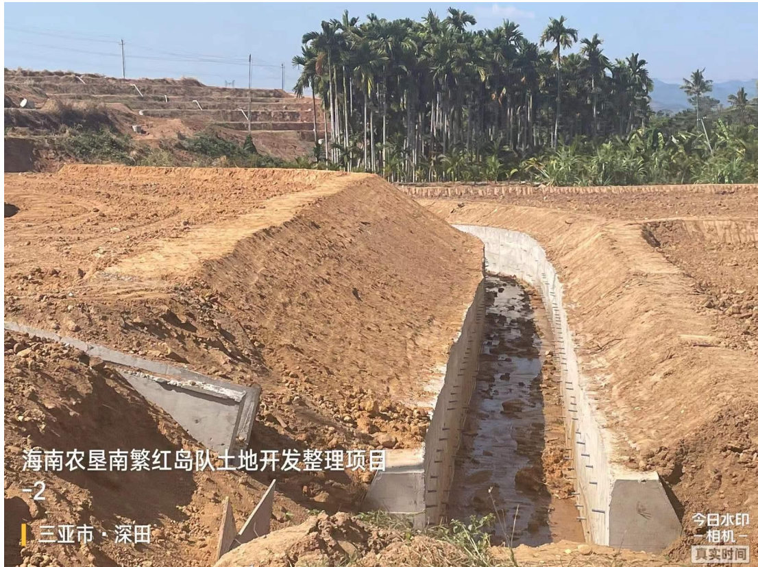
图 5-3 项目实施后现场照片 3
