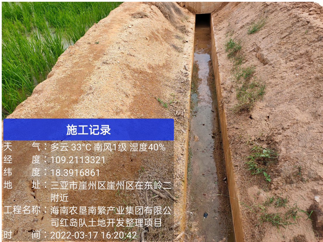
图 5-4 项目实施后现场照片 4
