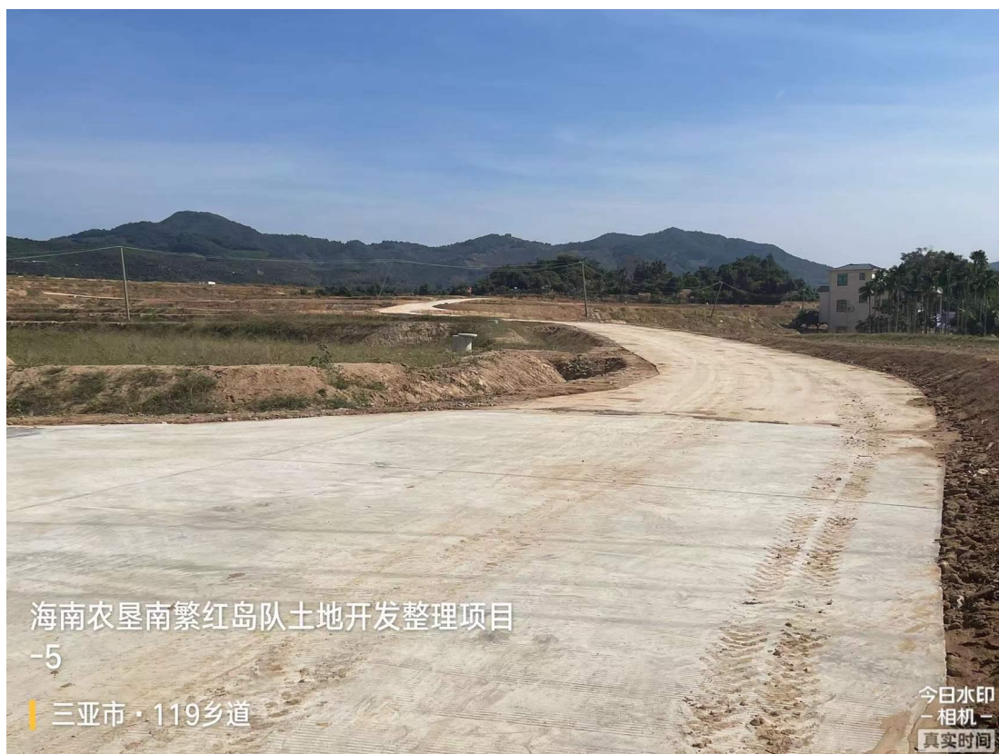
图 5-5 项目实施后现场照片 5
