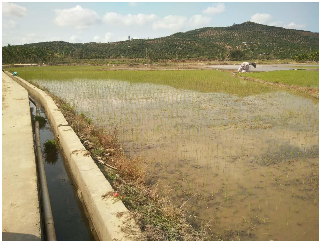
图 5-2 项目实施后现场照片 2
