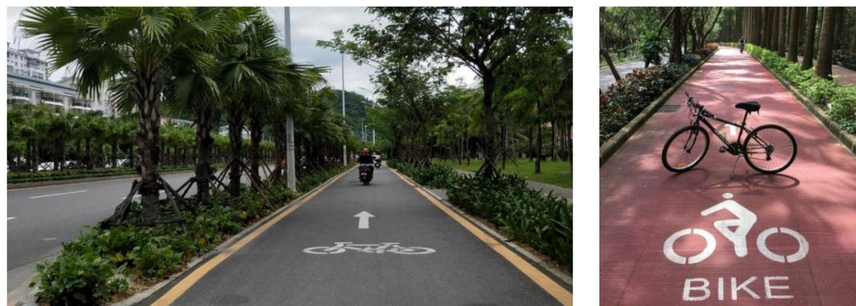
方式二：通过隔离带增加独立非机动车道，并通过非机动车道标识识别非机动车道
