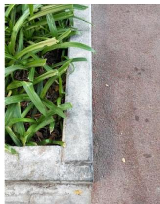
隔离带石面破损
