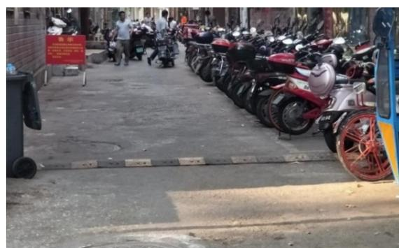
街巷出入口减速带无反光膜，不醒目
