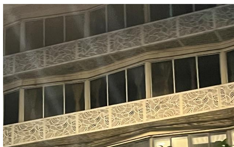
图2 空调室外机隐藏式处理
