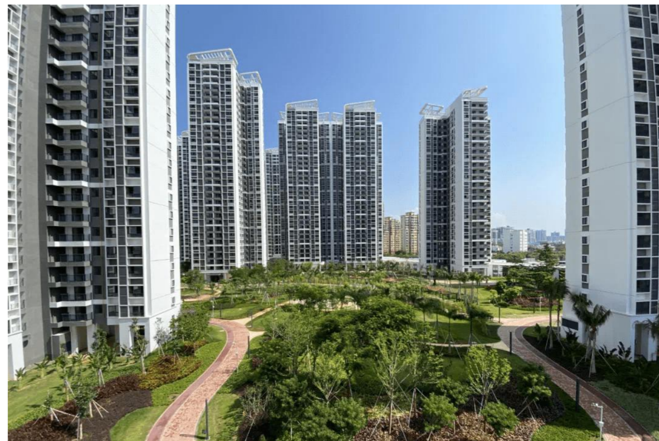
三亚市月川棚改安置区项目现场
