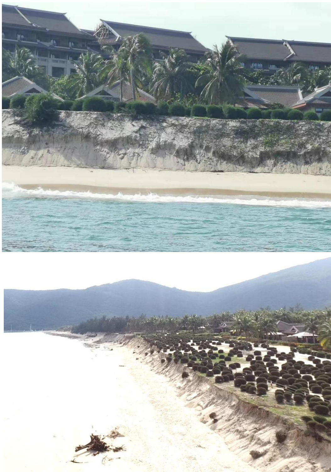
图 3.1.3-17 高潮大浪过后丽思酒店前沿沙坝的坍塌现象
