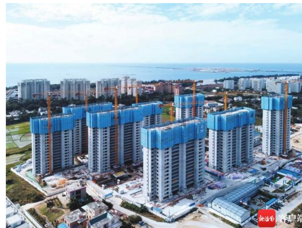
三亚布南安居房项目现场
