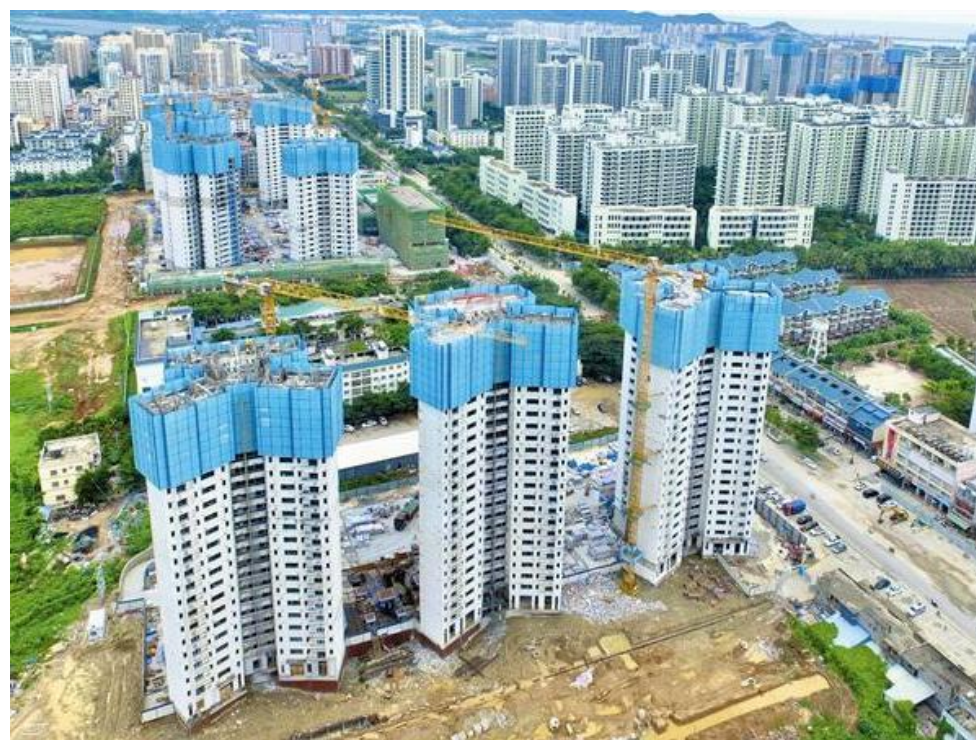
万科崖州安居房项目现场
