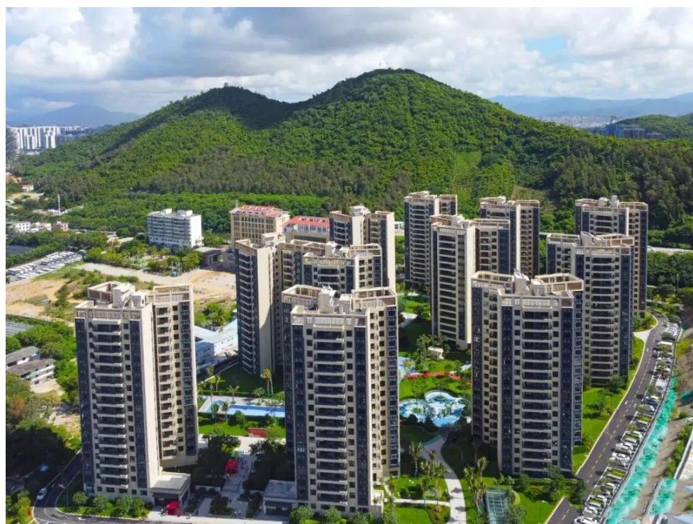
万科临春金色半山安居房项目现场
